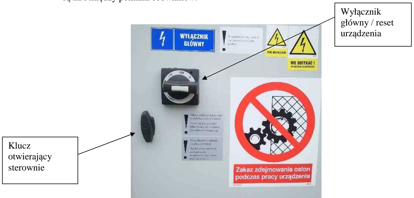
Rysunek 3 - Widok szafy sterowniczej
